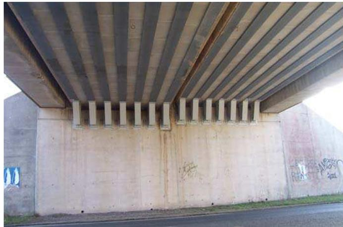
**Figure 4.22** – *Vue des tabliers et des bielles du pont-rail*
