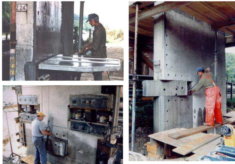
**Figure 5.23** – Installation des vérins sur la pile Koppigen
