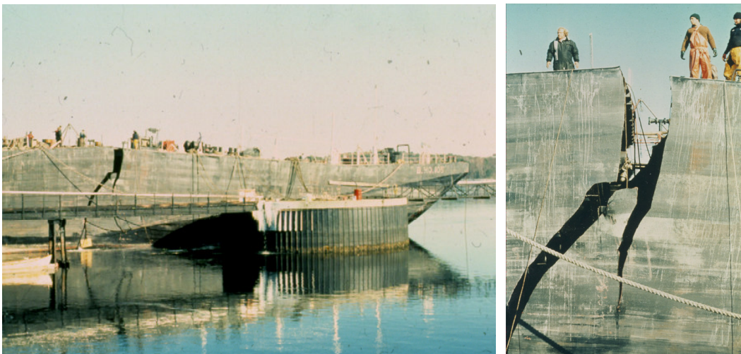
figure I. 1 : Photographie d'un liberty ship en acier bas carbone [Bouchard N-H, 1978]. Selon le rapport d'expertise de R.M. Pelloux, la fissure se serait amorcée à la jonction du pont et de la coque.
