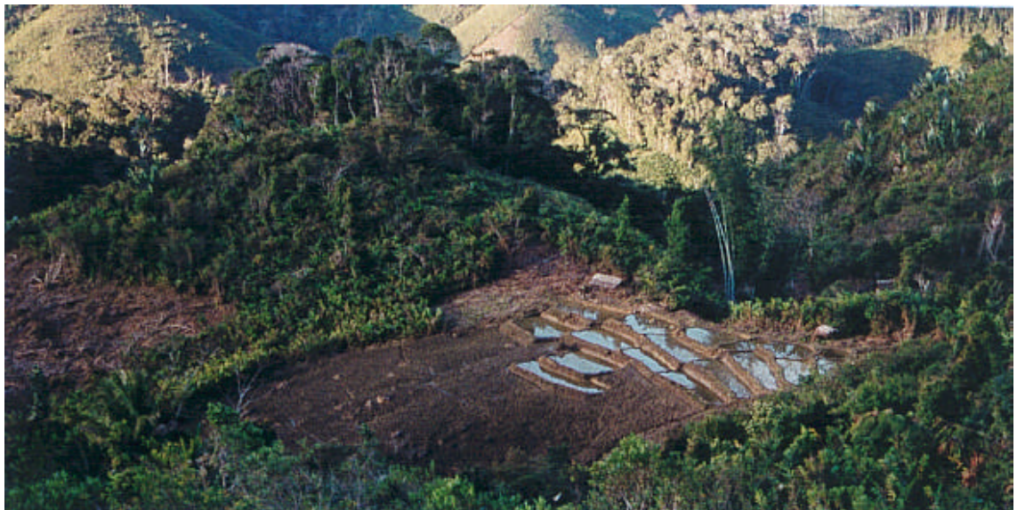
Photo 23 : une construction de terrasses en partant du haut d'un kirisana (vers Varary)
