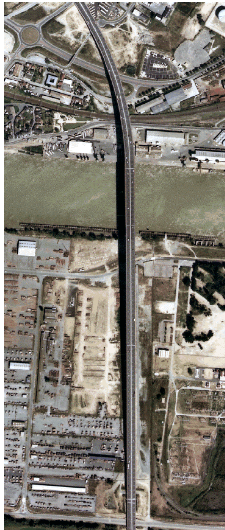
Figure 3.15. Vue aérienne du pont de Cheviré.
