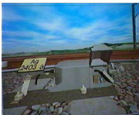
9. Il doit débloquer l'aiguille avec la clé moteur
