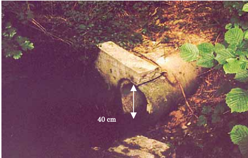
Photographie 7 : vue du collecteur "PZ5", depuis le fossé. L'axe du fossé est orienté du bas de la vue vers la gauche de celle-ci.
