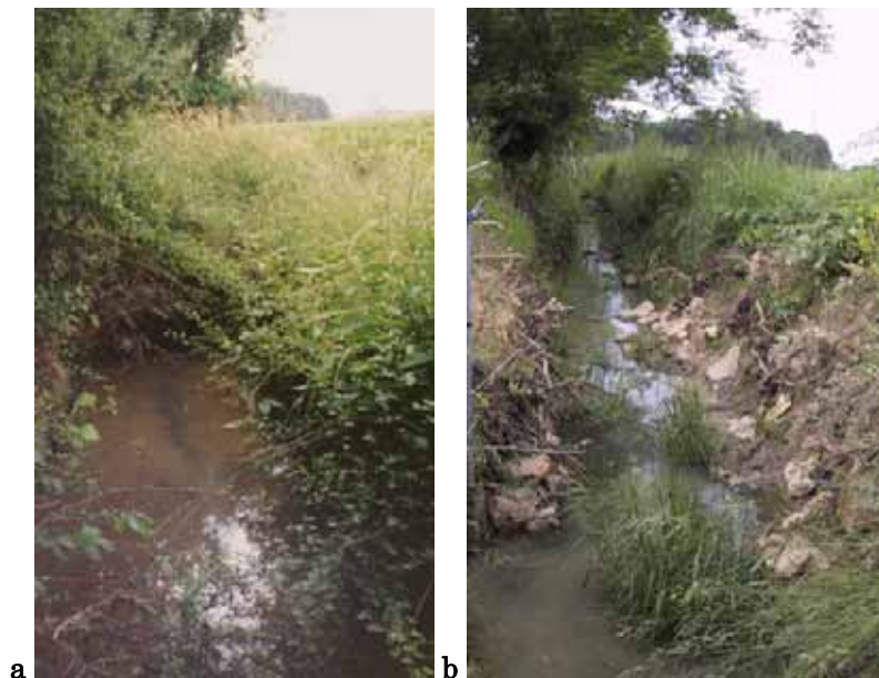
Planche 6 : vue du fossé, en direction de l'aval, au niveau de la buse "PZ2", (a) avant et (b) après sa suppression ; on distingue en (a) l'entrée plus sombre de la buse sous le feuillage, précédée sous l'eau d'un dépôt de sédiments visible.
