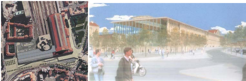
Figure 900, 901 Hall de l'extension à Marseille Saint-Charles (2003)
