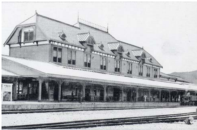
Figure 827 Takamatsu II (1910), toit en forme de triangle attaché au bâtiment
