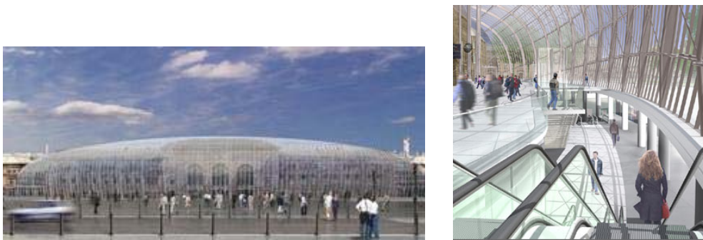
Figure 902, 903 Galerie devant le bâtiment principal à Strasbourg (2007)
