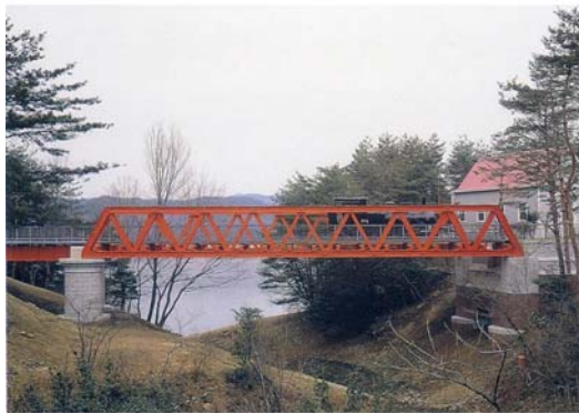
Figure 788 Pont de la Rivière de Rokugôgawa (1875)
