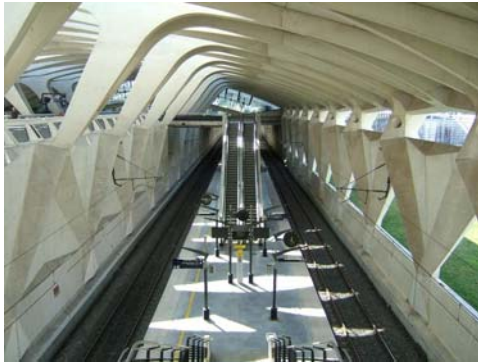
Figure 877 Halle en béton
