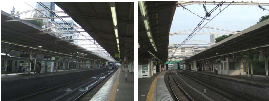
Figure 815, 816 Abris de quais à Tabata et à Uguisudani sur la ligne circulaire de Tokyo
