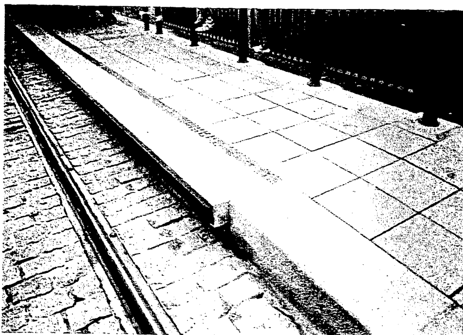
1i-18 Le tramway Saint-Denis-Bobigny : les traitements au sol (B) (photos prises sur le site)
