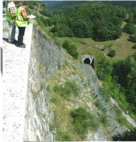
Figure 10 : auscultation d'un talus
