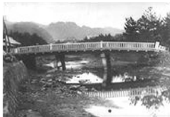
Figure 1.2 – Le séisme de Kanto (Japon) de 1923. Grands tassements et rotations au niveau de la fondation de piles de ponts. (Source : NISEE Library, http://nisee.berkeley.edu )
