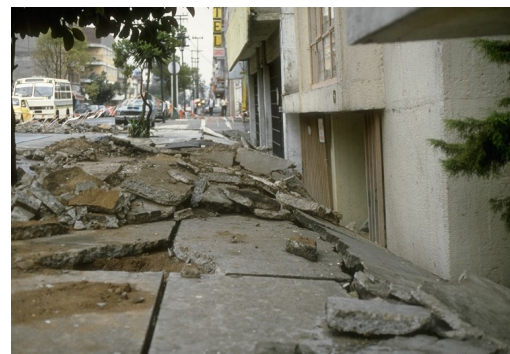
Figure 1.4 – Endommagements des structures au niveau de la fondation après le séisme de Guerrero-Michoacán (Mexique, 1985). (Images communiquées par Alain Pecker)
