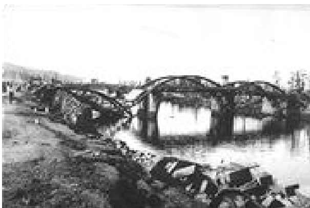
Figure 1.2 – Le séisme de Kanto (Japon) de 1923. Grands tassements et rotations au niveau de la fondation de piles de ponts. (Source : NISEE Library, http://nisee.berkeley.edu )
