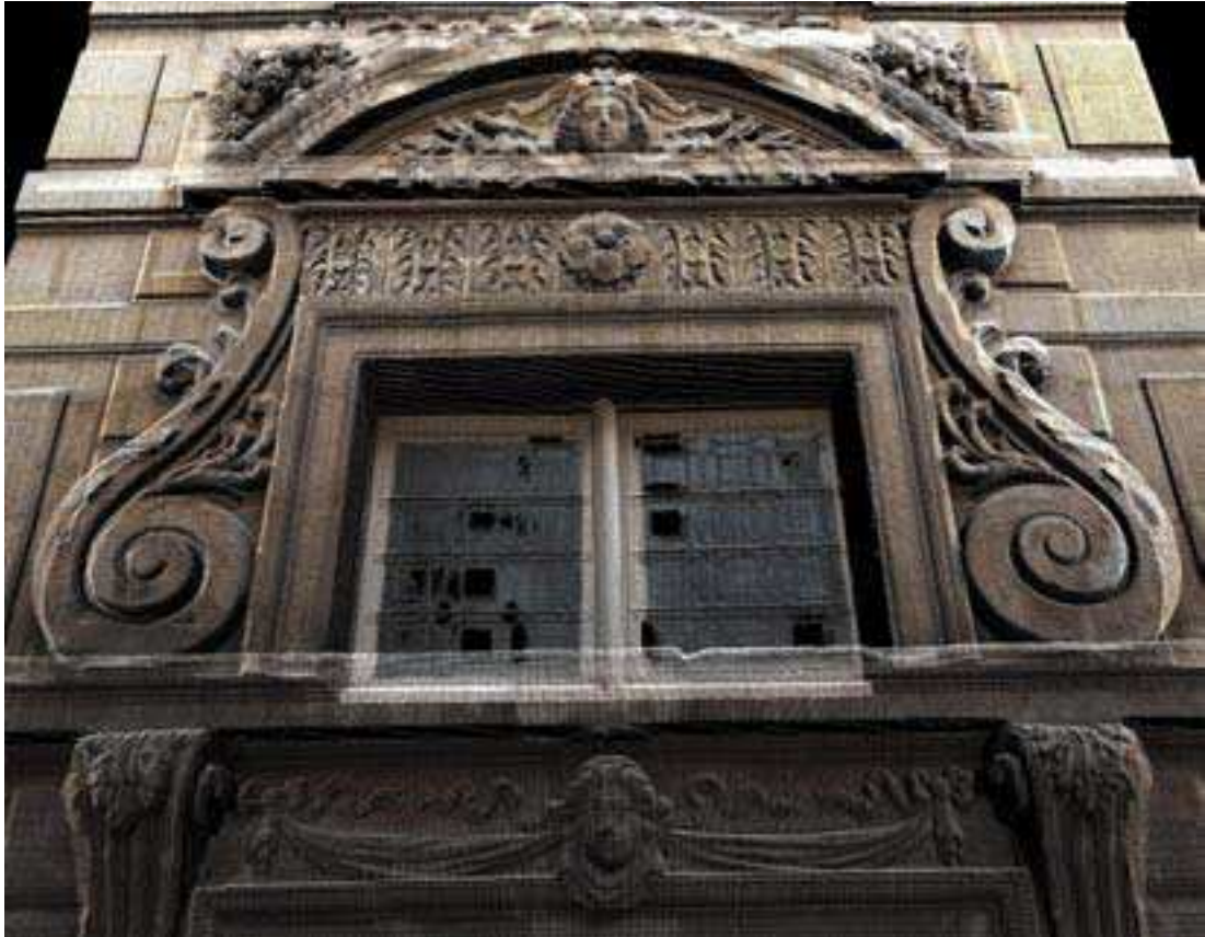
Figure 75. Coloration du nuage de points d'un élément de décor à partir d'une photographie orientée. Hôtel de Sully, Paris.
