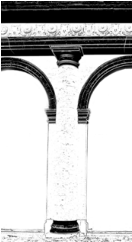
Figure 39. Éléments moulurés (en noir) dans un module de l'édifice examiné.
