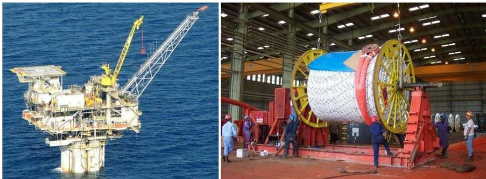
Figure I-7 : A gauche, une plate-forme de l'exploitation Red Hawk ancrée avec des lignes polyester ([www.offshoretechnology.com](http://www.offshoretechnology.com)) ; à droite, le stockage des lignes en PET avant installation ([www.delmarus.com](http://www.delmarus.com)).
