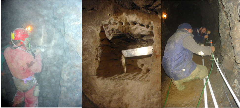
FIG. C.8 – De gauche à droite : Délimitation de la position de la niche Sud à l'aide d'une disqueuse Diamant, par Michel Kammenthaler. Niche sud percée, a noter les trous de pré-perçage. Frédéric Boudin et Claude Courteil vérifiant l'horizontalité entre 2 équerres successives.
