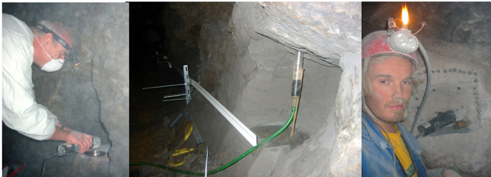
FIG. C.9 – De gauche à droite : Surfaçage d'une niche par Patrick Longuevergne. Niche nord surfacée accueillant le système de nivellement hydrostatique pour vérifier que le niveau relatif entre les 2 niches soit de l'ordre du millimètre.
