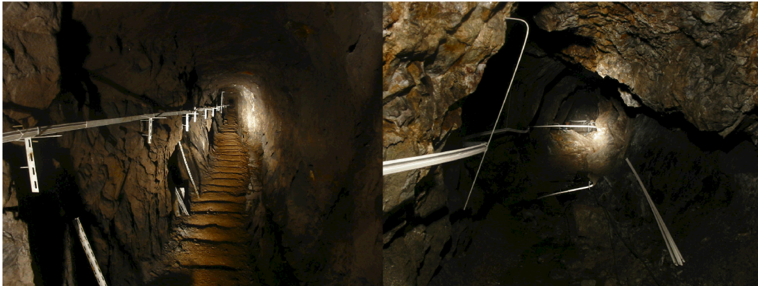
FIG. 2.4 – Photo des deux inclinomètres installés. A gauche, l'instrument orienté N37° E installé dans un travers banc. A droite, l'instrument orienté N120° E, installé dans le filon exploité, instable. A noter la nécessité de s'adapter aux zones d'éboulements dans cette dernière galerie.
