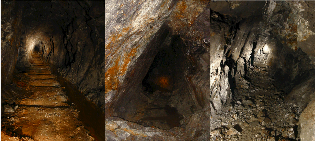
FIG. C.7 – Galeries de la Mine WilhelmStollen. De gauche à droite : travers banc principale, rectiligne, à noter le ruisseau d'exhaure sur la droite. Galerie dans le filon, partie est, à noter le pendage de 70^{\circ}E et la puissance du filon de 50 cm. Galerie dans le filon, partie ouest.
