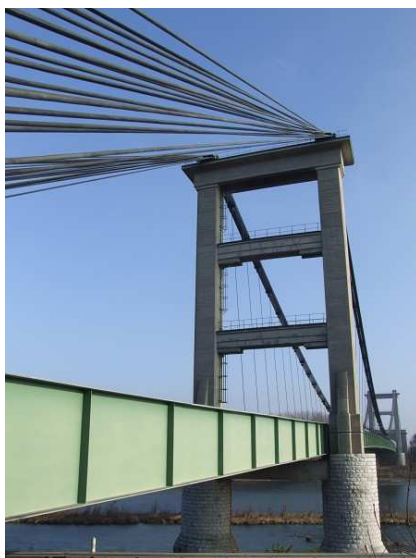
(a) Pont du Teil
