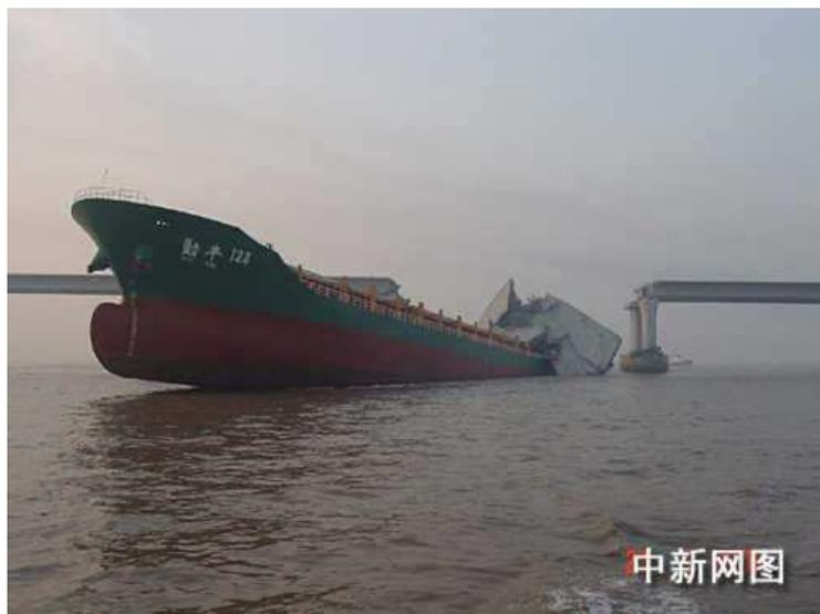
FIG. 2.5 – Effondrement du Jiujiang bridge en Chine suite à un choc de bateau en 2008
