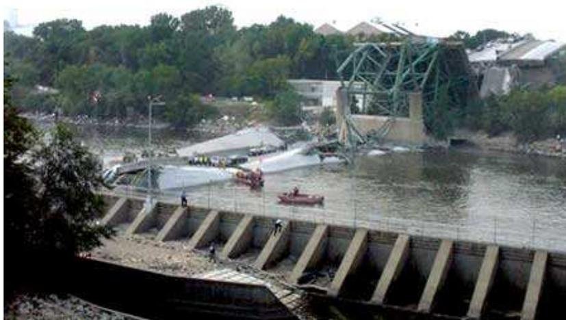
FIG. 2.1 – Effondrement du pont de Minneapolis en août 2007
