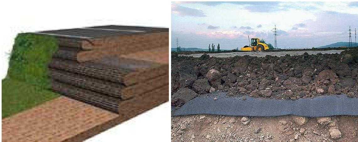
Figure 1-6: Mise en place de géosynthétiques
