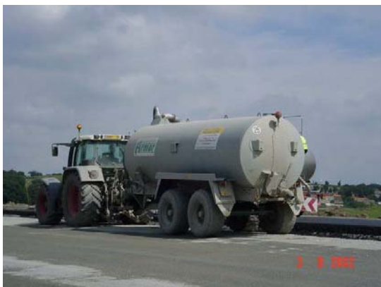
Arroseuse munie d'un accessoire d'arroser les matériaux de la CBF
