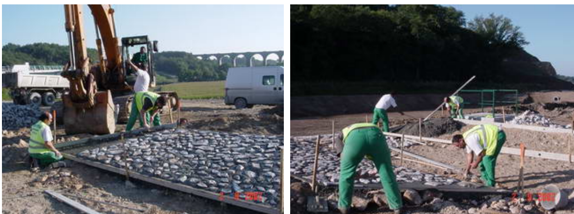
Une équipe de construction des bassins d'eau
