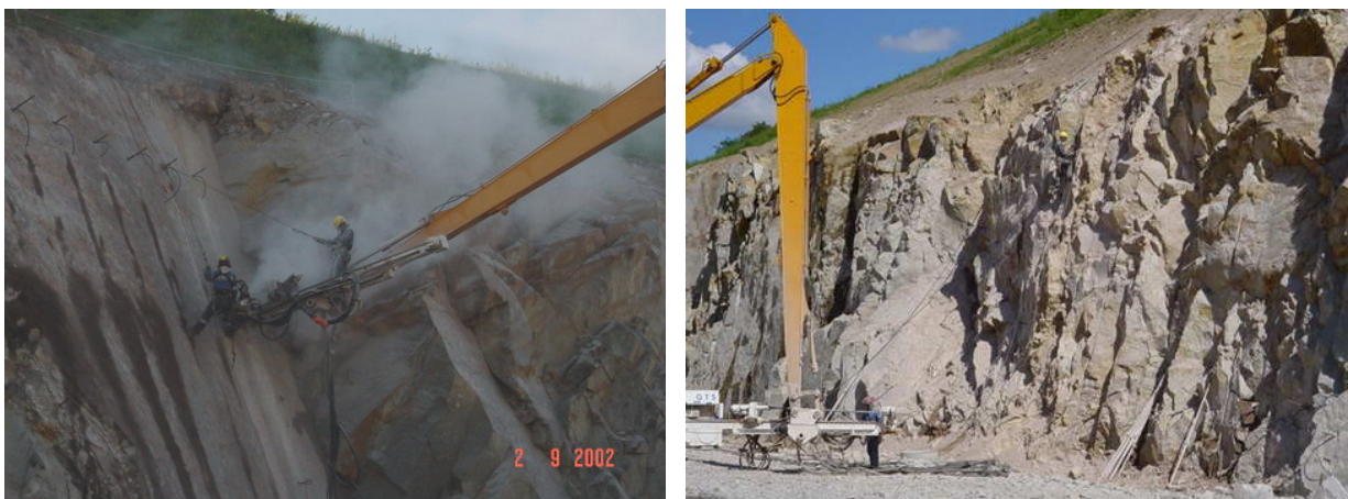
Forage et mise en place de l'explosif pour le tir
