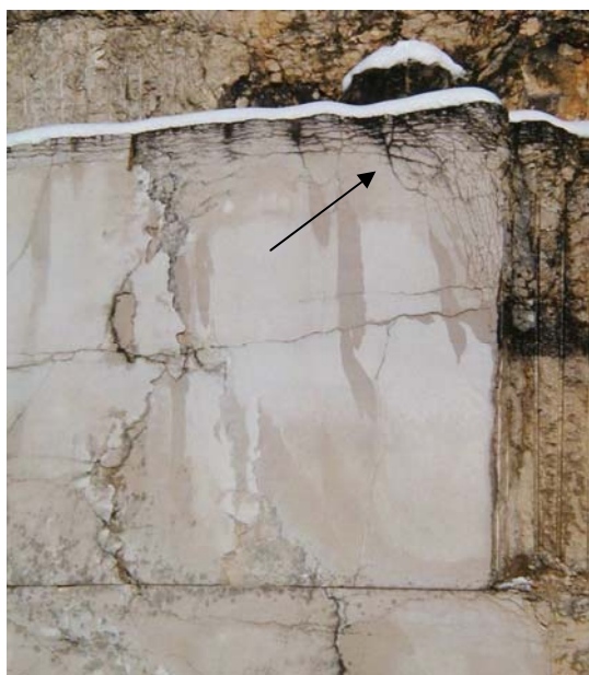
Figure 42. Affleurement de Larrys perlé altéré en carrière.
