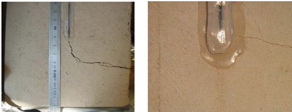
Figure 129. Fissuration en fond d'entaille des cubes de 15cm de côté : Chamesson à gauche, Pierre de Lens à droite.
