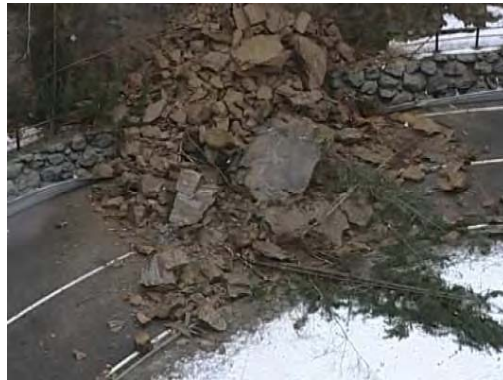
Figure 7. Allure des gelifracts (Route du Mont-blanc, mars 2007) (« gelifracts » = les fragments rocheux issus des effets du gel).
