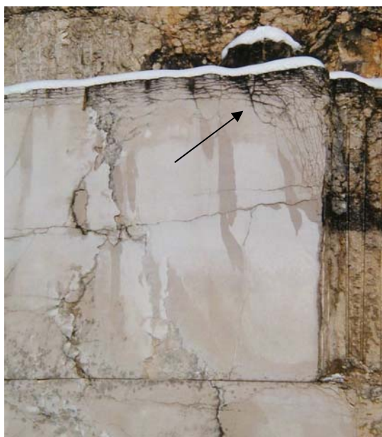
Figure 42. Affleurement de Larrys perlé altéré en carrière.
