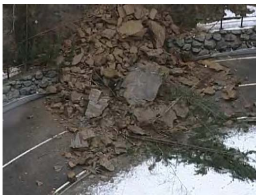
Figure 7. Allure des gelifracts (Route du Mont-blanc, mars 2007) (« gelifracts » = les fragments rocheux issus des effets du gel).
