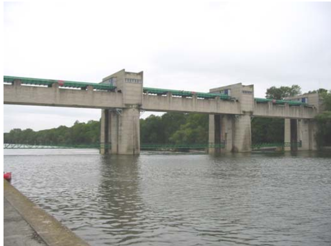
Figure 10 : Site du barrage d'Andrésy (vue amont juin 2007)
