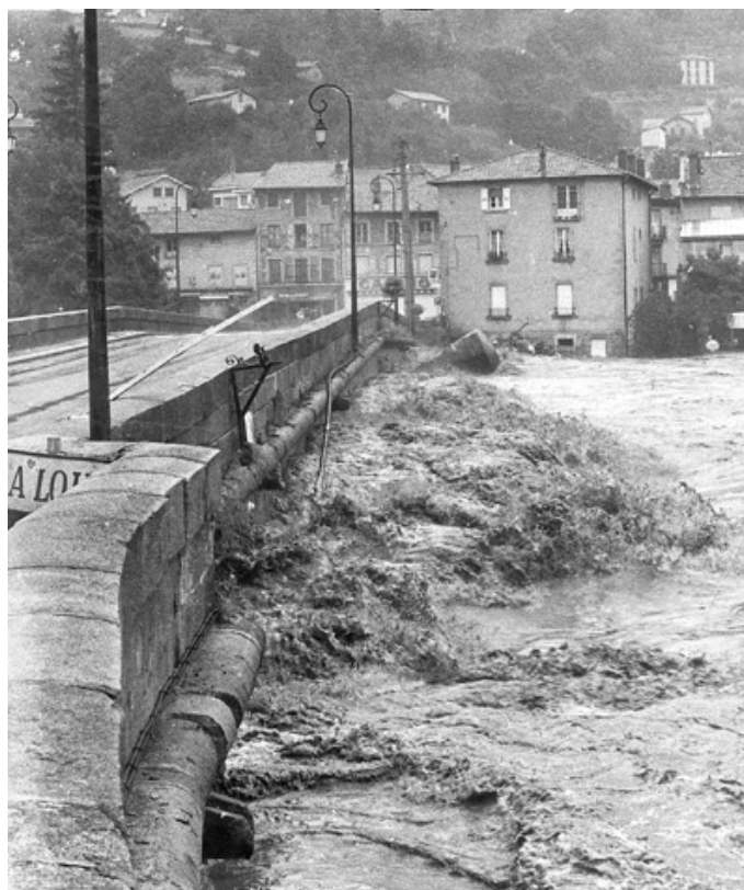
FIG. A.103 – Crue de Septembre 1980 au pont de Brives (Source :L'éveil de la Haute-Loire).
