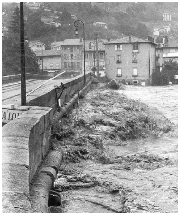
FIG. A.103 – Crue de Septembre 1980 au pont de Brives (Source :L'éveil de la Haute-Loire).
