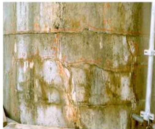
Figure 2-2 Désordres sur la culée du pont d'Onde
