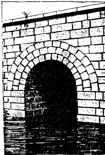
Bouche d'égout sur le Tibre.
