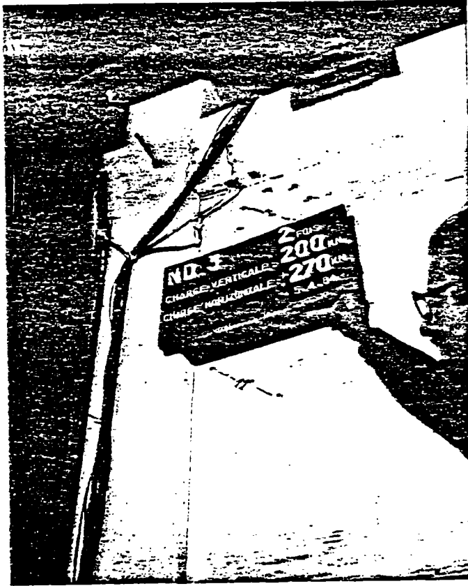
Fig. 3.3.1.4. - DEBUT DE FISSURATION DU CADRE
