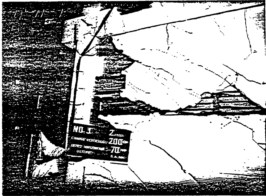
Fig. 3.3.1.10 - ETAT D'ENDOMMAGEMENT DE LA MACONNERIE COTE NORD
