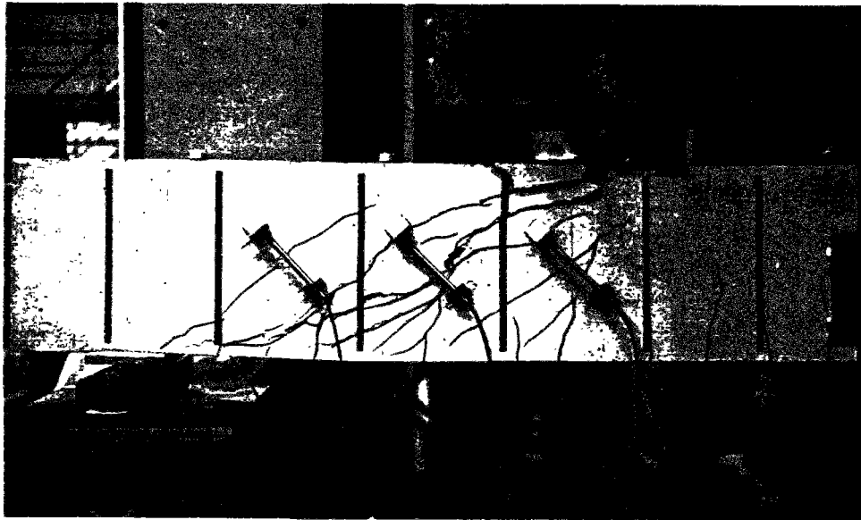
Figure 4.3.7 - Rupture de la poutrelle BHPA1.
