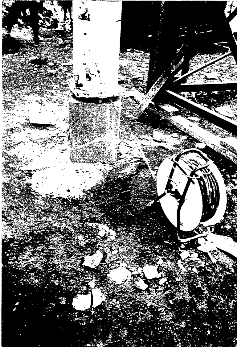
Figure IV.20 : Etat du terrain et de la partie solidaire de la tête du pieu après la rupture.
