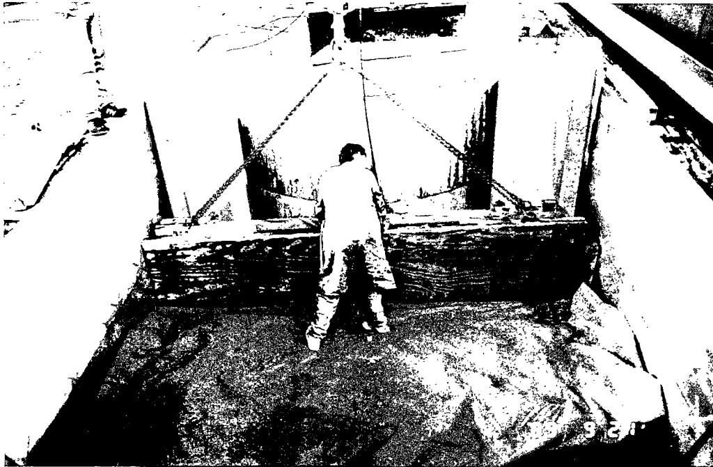
Figure 4.29 - Construction du mur expérimental : mise en place du coffrage
