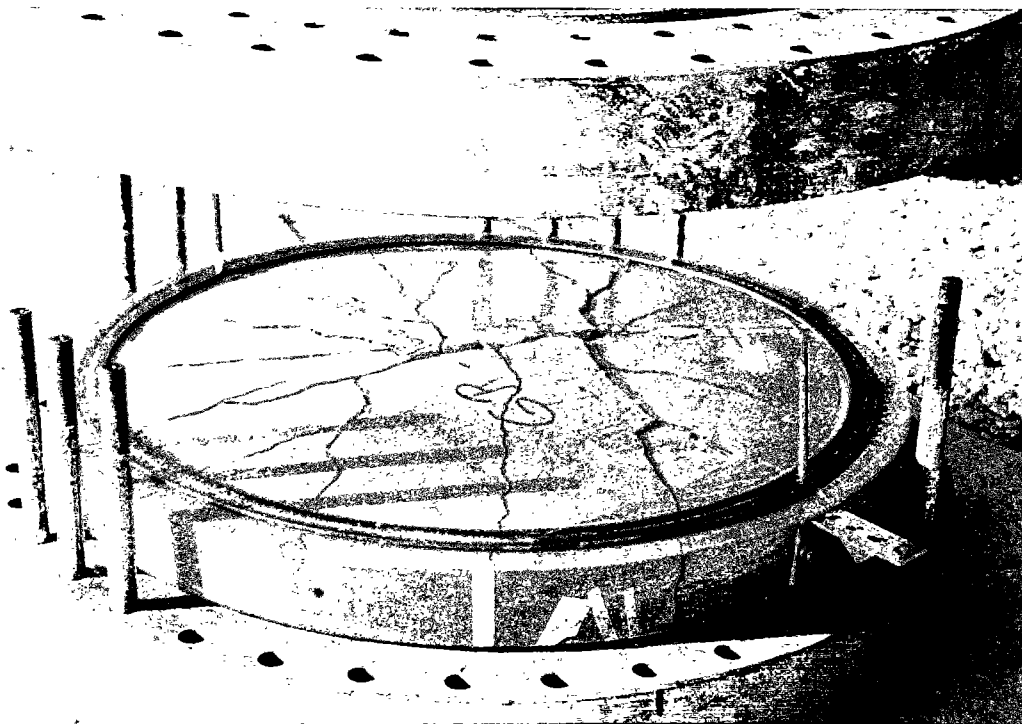
Figure 2.2-14 : Démontage. Vue de l'appui (couronne acier-caoutchouc)
