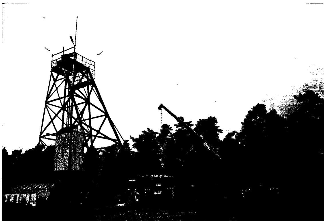
↑ Puits d'accès (ascenseur).
