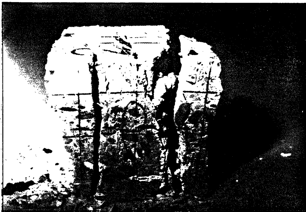
Photo III.101 : Fissuration dans le cas biaxial
