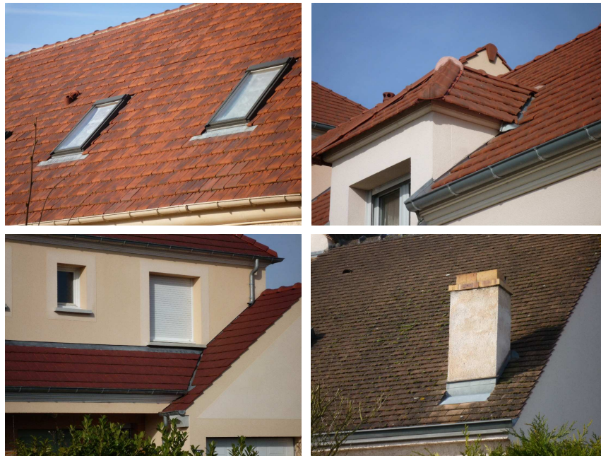
Figure 128 : Photographies illustrant l'emploi de métaux pour les éléments singuliers des toitures, avec de gauche à droite et de haut en bas : étanchéités de fenêtres de toit, rive et noue métalliques mises en œuvre sur un chien-assis, rive contre un mur et noue d'évacuation des eaux pluviales sur un toit présentant plusieurs pans, raccords de pénétration de cheminée.
