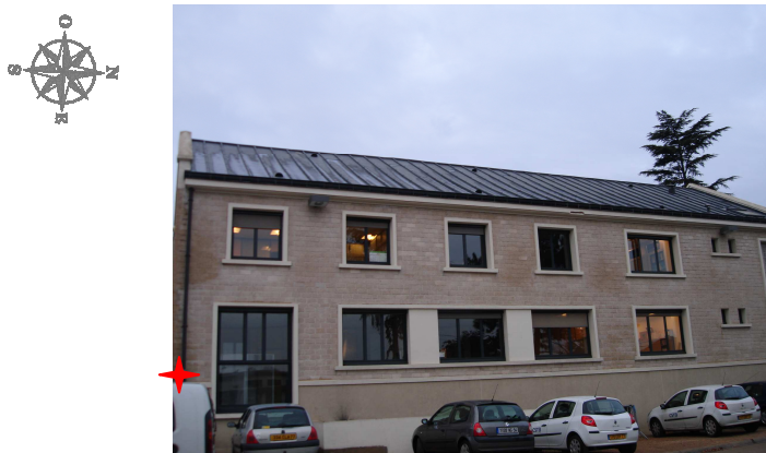
Figure 100 : Photographie de la face est du bâtiment B1 – CSTB – Champs-sur-Marne
