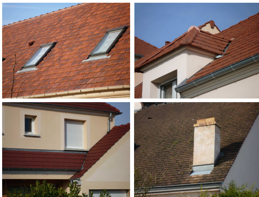
Figure 128 : Photographies illustrant l'emploi de métaux pour les éléments singuliers des toitures, avec de gauche à droite et de haut en bas : étanchéités de fenêtres de toit, rive et noue métalliques mises en œuvre sur un chien-assis, rive contre un mur et noue d'évacuation des eaux pluviales sur un toit présentant plusieurs pans, raccords de pénétration de cheminée.
