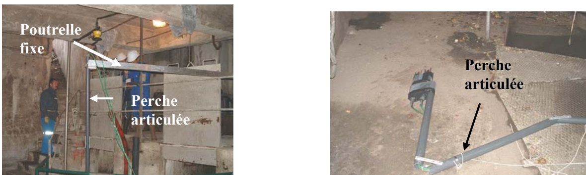
Figure 15 : Système de maintien initial des sondes sur le site de Duchesse Anne à Nantes : perche articulée + poutrelle fixe
