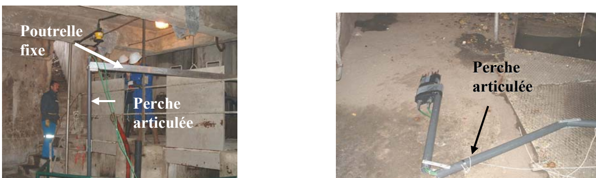
Figure 15 : Système de maintien initial des sondes sur le site de Duchesse Anne à Nantes : perche articulée + poutrelle fixe
