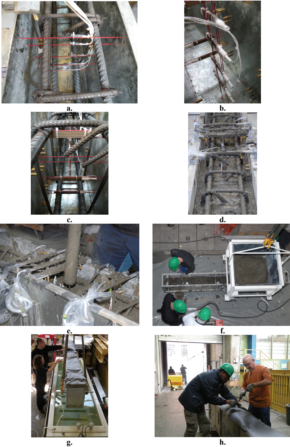
Figure 2-64 : fabrication de poutres
