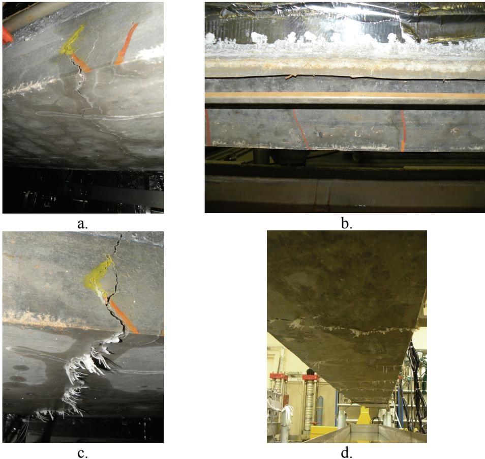
**Figure 4-61 : fissuration de la poutre P5 (partie 1)**
