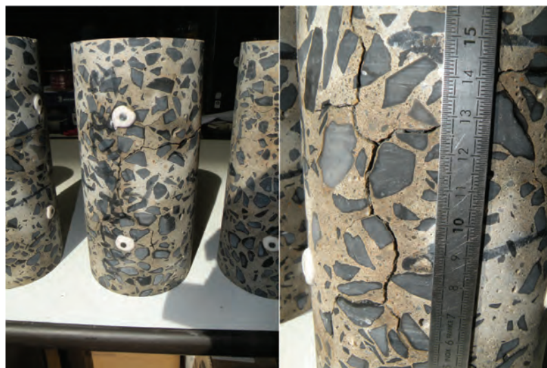
Figure 3-22 : fissuration des éprouvettes R2_GLA après 130 jours d'exposition
