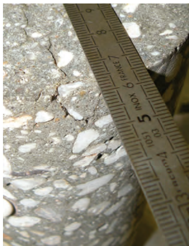
Figure 3-3 : fissuration d'une éprouvette de gonflement libre R1 après 450 jours de conservation en eau
