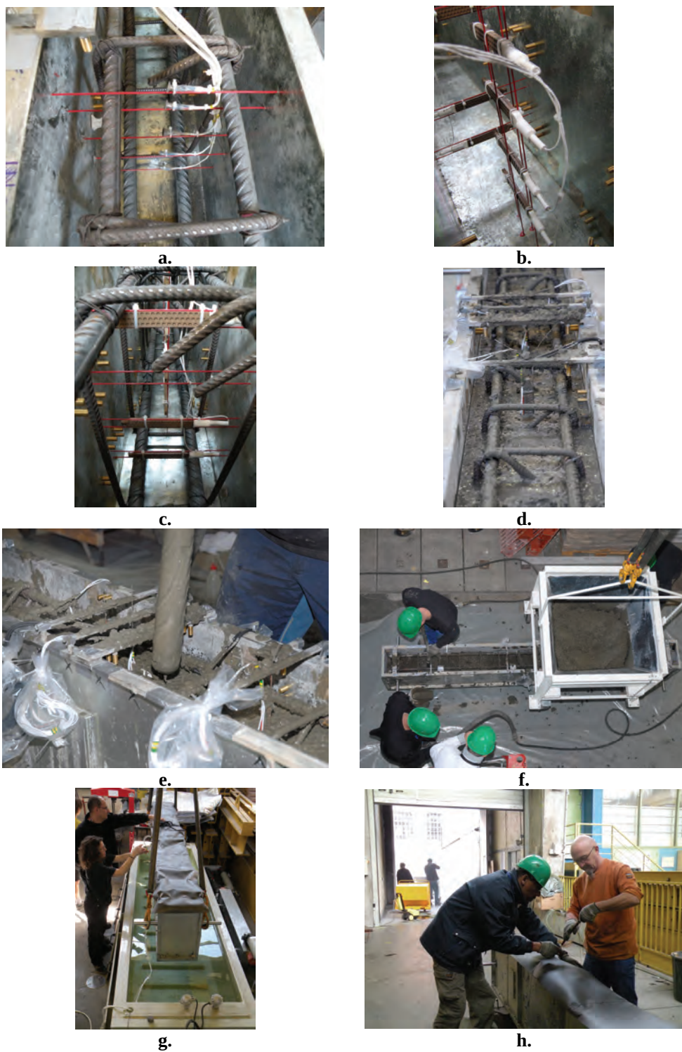
Figure 2-64 : fabrication de poutres
