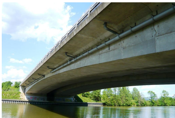
FIGURE 6.2 – Vue de l'ensemble du pont PI-57.
