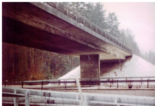
(a) Vue du pont
