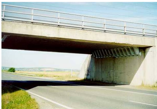
FIGURE 5.2 – Vue de l'ensemble du pont-rail.
