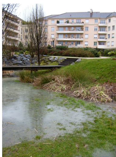
(c) Bassin aval par temps de pluie
