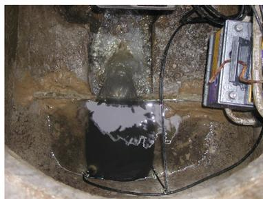
FIG. 8.2: Exemple d'un déversoir triangulaire, vue d'en haut
