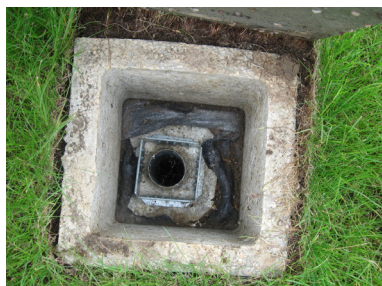
(c) Système de drain du toit
