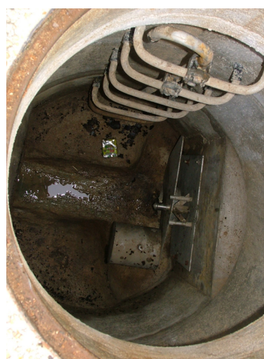
(d) Régulateur à flotteur
