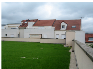
(a) Toit stockant
