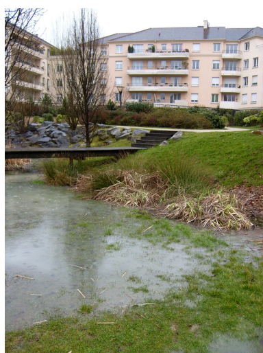
(c) Bassin aval par temps de pluie
