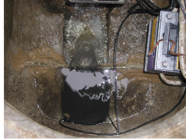
FIG. 8.2: Exemple d'un déversoir triangulaire, vue d'en haut
