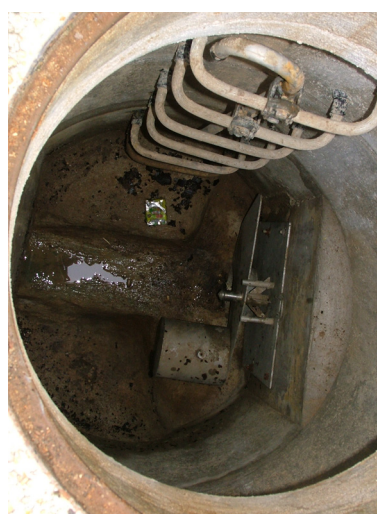
(d) Régulateur à flotteur
