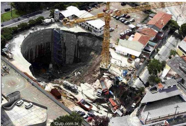
Figure 1.1 - Exemple d'effondrements au cours de construction des tunnels de métro.
