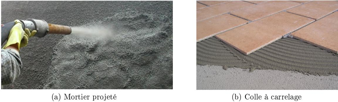
FIGURE 1.1 – Images de différentes applications du mortier utilisant les éthers de cellulose
