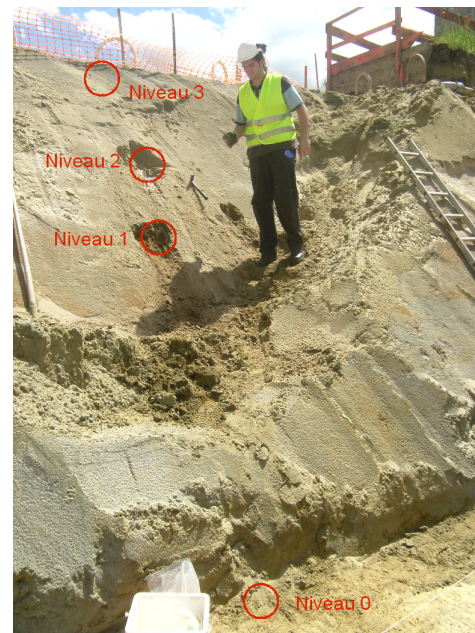
FIGURE 3.8 – Vue de l'emplacement des quatre carottes.
