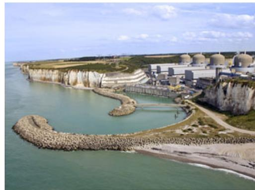
FIGURE 2 – Centrale nucléaire de 1300 MW sans aérorfrigérant
