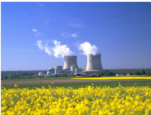
FIGURE 1 – Centrale nucléaire de 900 MW avec aérorfrigérant (2nd type)
