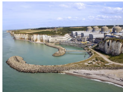
FIGURE 2 – Centrale nucléaire de 1300 MW sans aérorfrigérant
