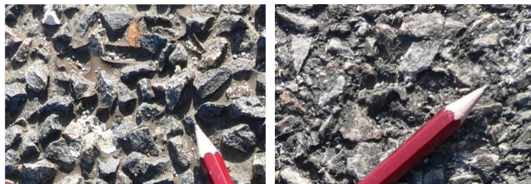
FIGURE 4.31 – Surfaces de la chaussée A (à gauche) et E2 (à droite) [52]
