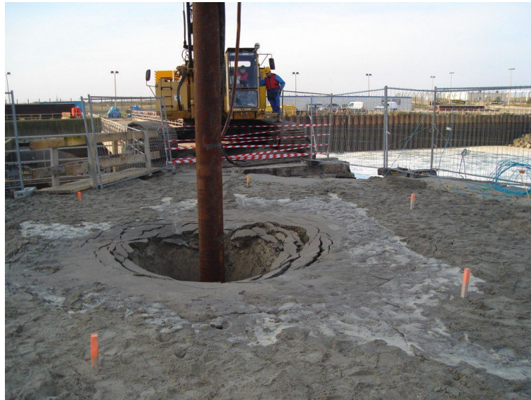
FIGURE 2.10 – Vibrocompactage sur le site d'EDF Gravelines (59) - 2006 (source Keller-France)
