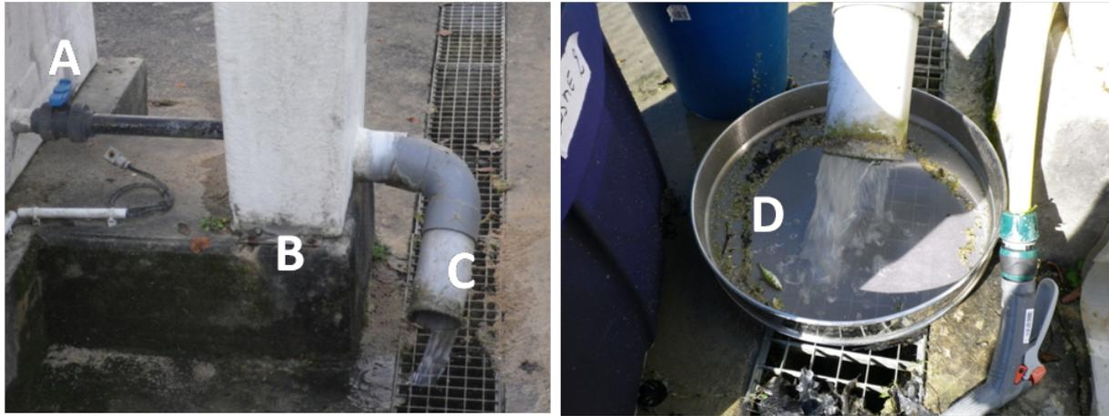
FIGURE 2.22 – Système de vidange des canaux.
