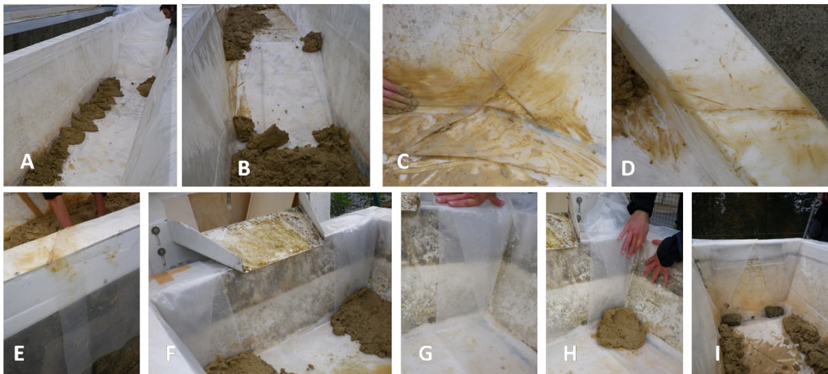
FIGURE 2.16 – Mise en place de la bâche de polyéthylène dans les canaux.
