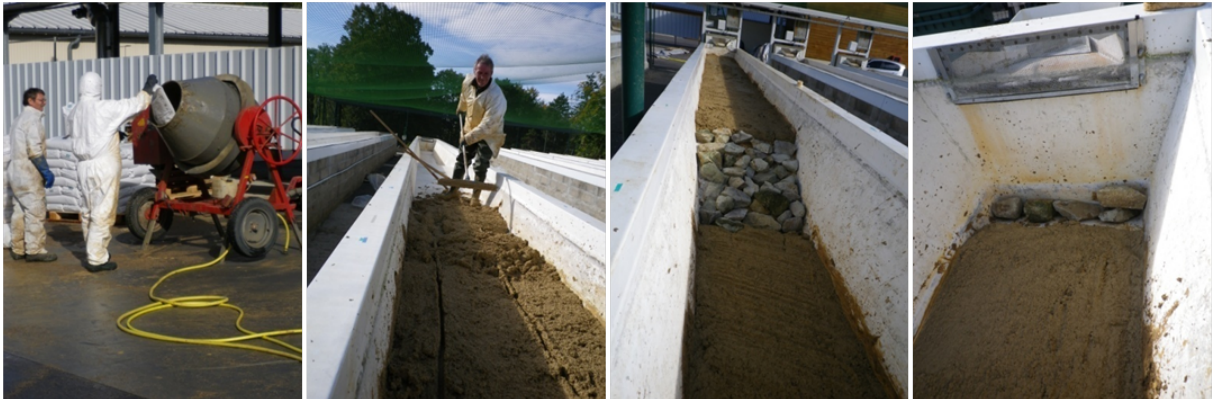
FIGURE 2.17 – Mise en place du sédiment dans les canaux.
