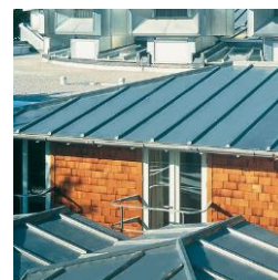
Figure 58 : Couverture en zinc à tasseaux
