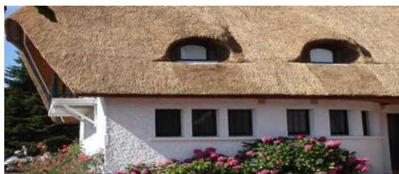
Figure 51 : Toiture en chaume
