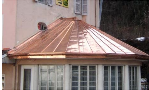
Figure 14 : Toiture en cuivre
